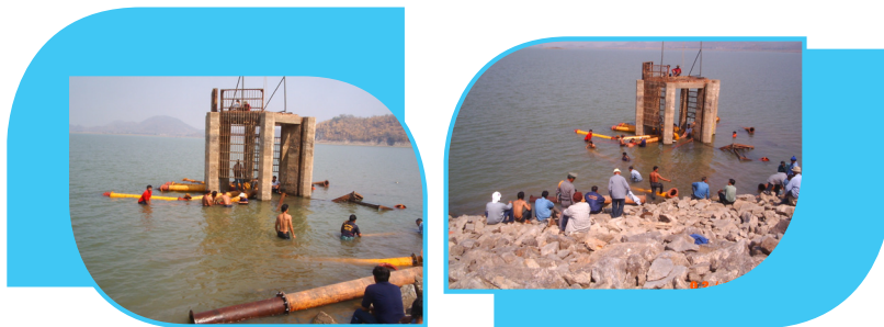
การติดตั้งทำกาลก้นน้ำในอ่างเก็บน้ำกระเสียว
